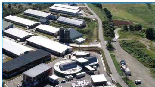
牛舎とながめやまバイオガス発電所
